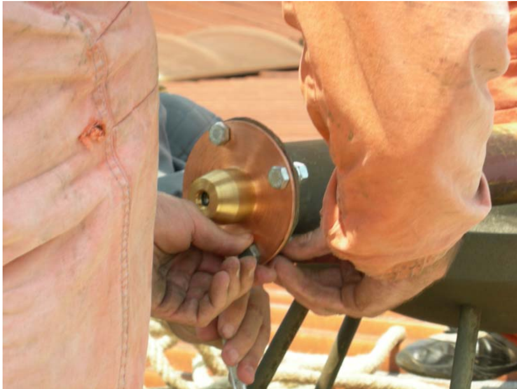
Slika 12: Priprema podnožja za novi gromobran
