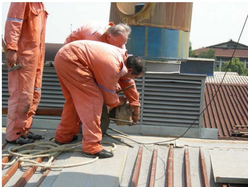
Slika 7: Stavljanje kontejnera na radioaktivni gromobran
