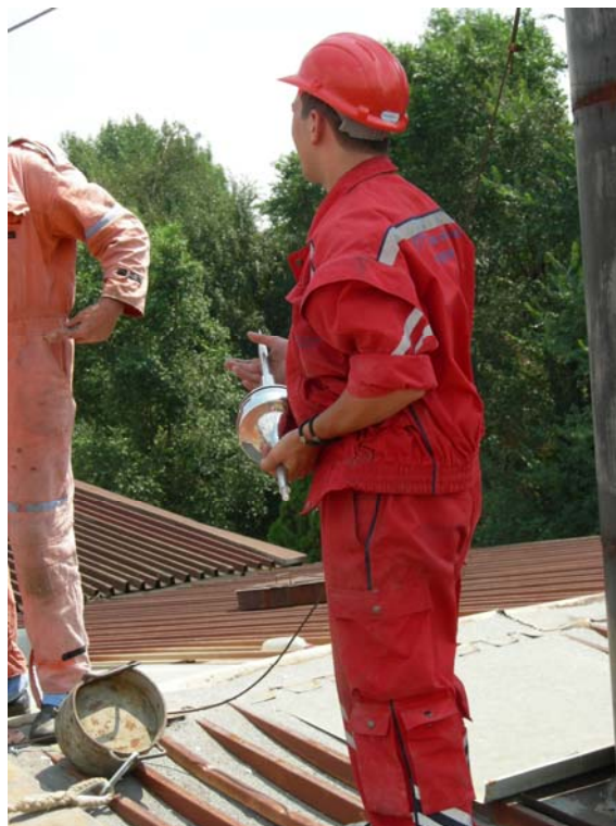
Slika 11: Novi gromobran sa ranim startovanjem
