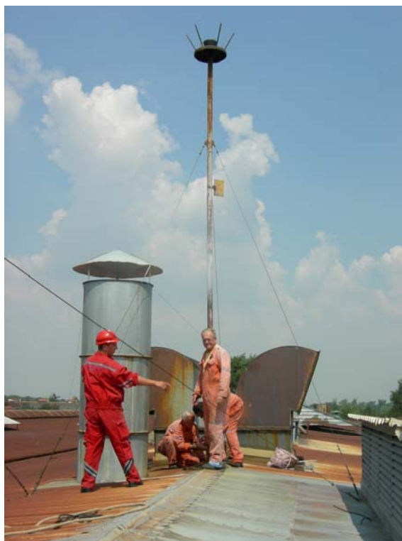
Slika 1: Izgled starog radioaktivnog gromobrana
