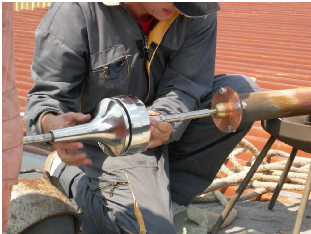
Slika 13: Montaža novog gromobrana
