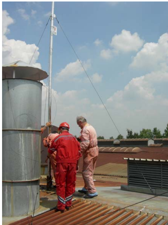
Slika 17: Ankerisanje stuba i pričvršćenje traka
