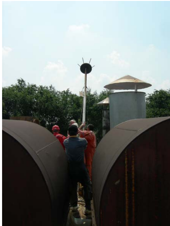
Slika 4: Spuštanje cevi na kojoj se nalazi radioaktivni gromobran
