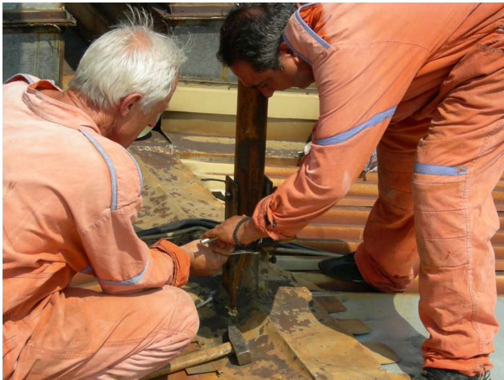
Slika 3: Odvajanje gromobranskih traka od pocinkovane cevi
